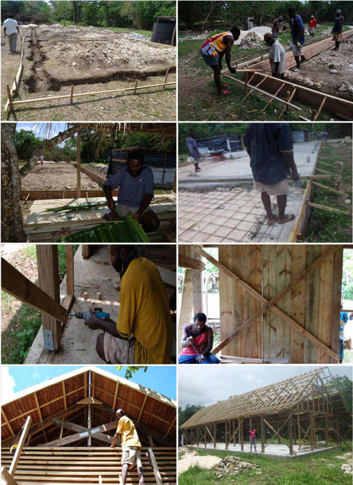
Figure 5: Construction (Kaunitz 2012a)
